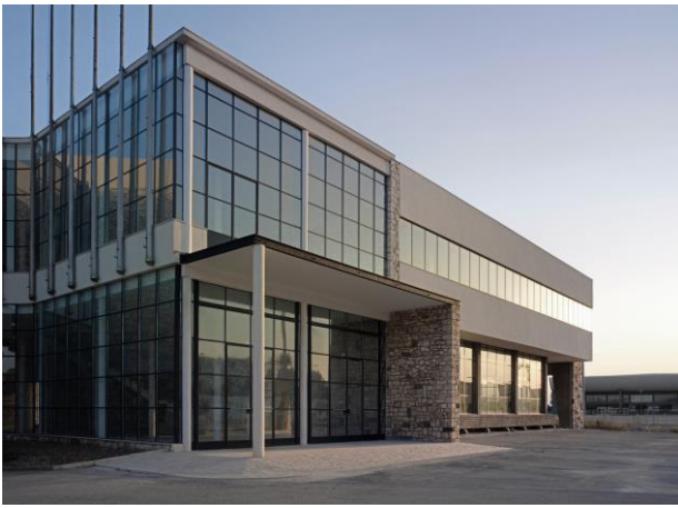
Fig.01 – Vista della facciata principale (Alberto Muciaccia 2016)
