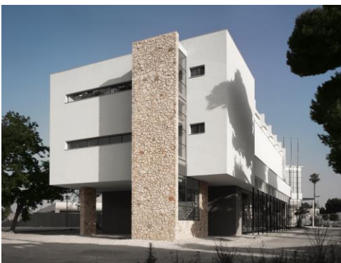
Fig.10 –Vista prospetto Est di completamento (Alberto Muciaccia 2016)
